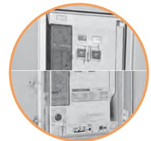
→ Дверная рамка позволяет обеспечить защиту IP20 (как декоративная панель), при использовании специальной резиновой прокладки обеспечивается степень защиты IP31. Также имеется специальная рамка, обеспечивающая IP55 (остается закрепленной на выключателе даже в положении "ISOLATED")
