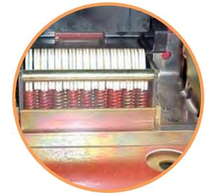
→ Конструкция ETIPOWER позволяет заземлить шинпровод со стороны питающей линии или нагрузки низковольтной сети
