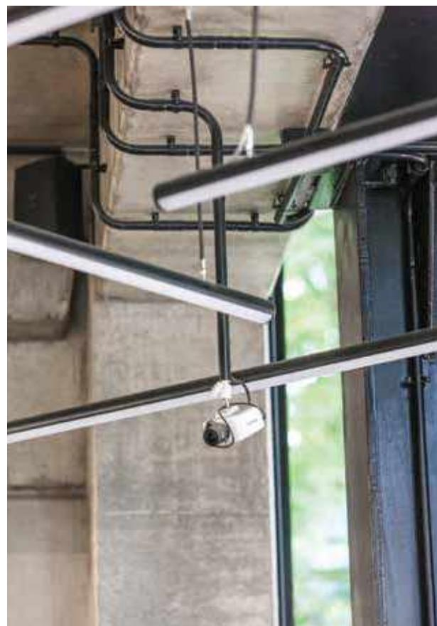
**Монтаж ліній відеонагляду в електротехнічних трубах для захисту від електромагнітних перешкод**
