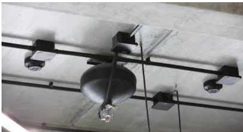
**Заправочні станції «Socar». Підключення систем пожежогасіння відповідно до вимог ДСТУ кабельною лінією з вогнестійкістю P90**
