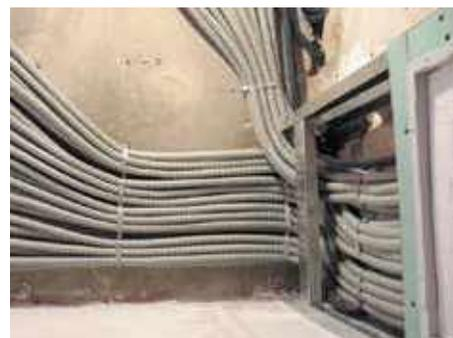
Приховане прокладання в штробах стін, технічних шахтах, пустотах будівельних конструкцій
