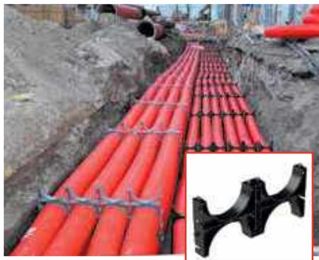
Рис. 1. Застосування кластерів для багаторівневої кабельної каналізації.
